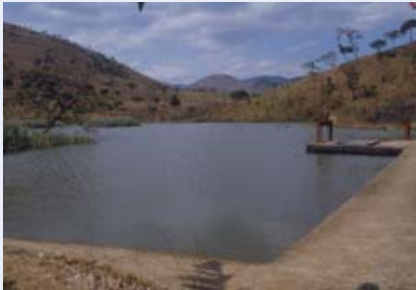
Lugarawa: der Stausee, die Station, die Generatoren.
